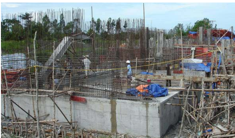
Hình 7. Thi công 7 cống xà lan trong hố móng- Hậu Giang
