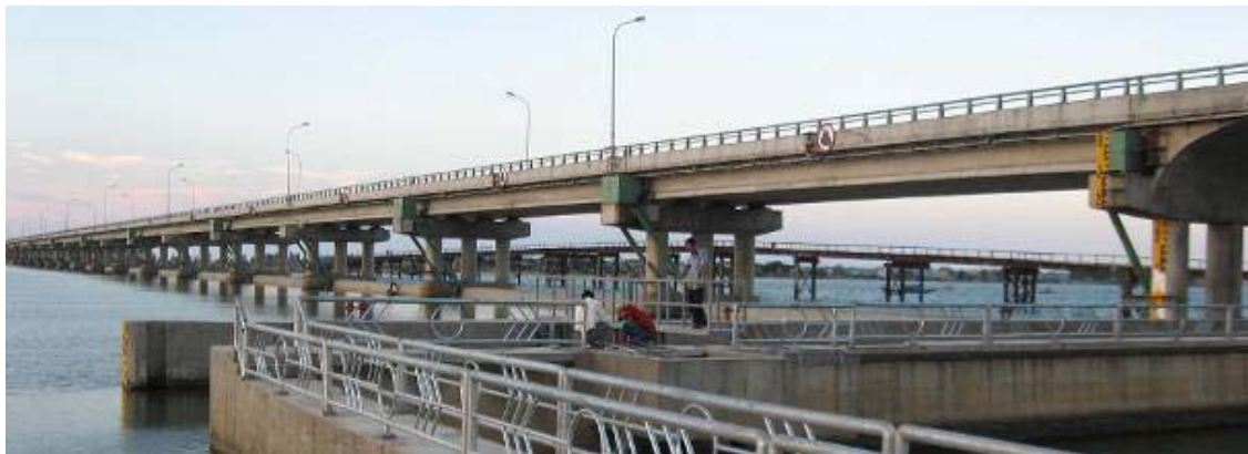
Hình 12. Công trình Tháo Long khi hoàn thành
